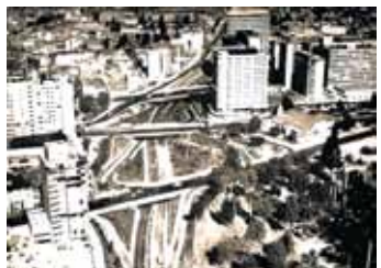
> Aérea Puentes Calle 26 <
